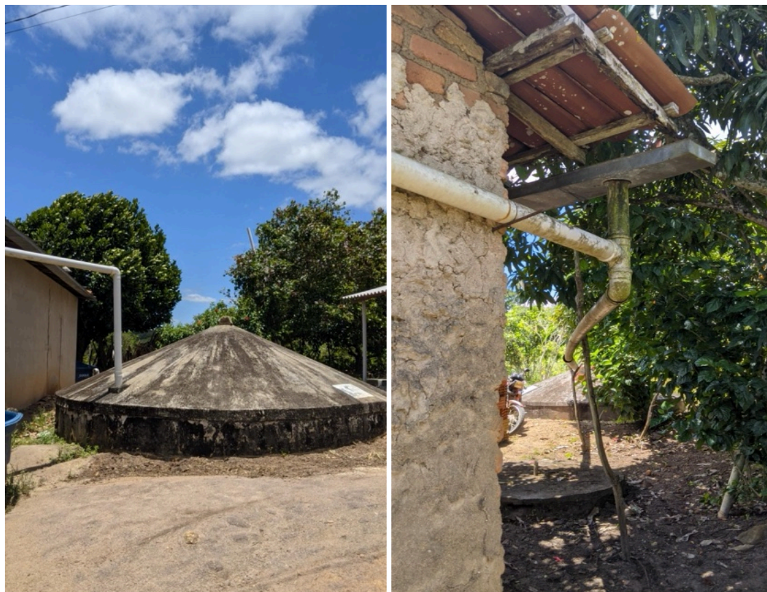
Imagem 36. Sistema de captação de água da chuva no Quilombo Senhor do Bonfim
