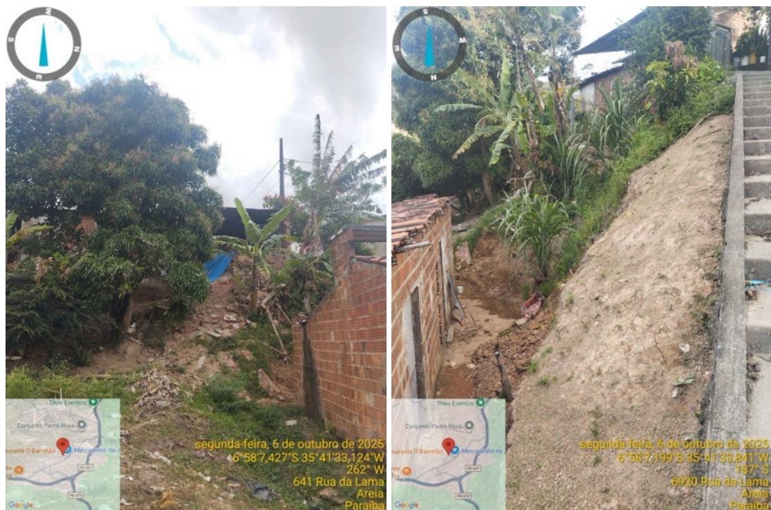
Imagem 40. Base de encostas com indícios de movimentação de massa e erosão em Jussara
